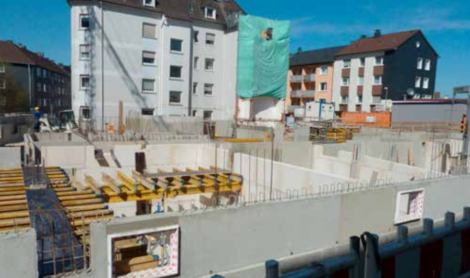
Remscheid, Stuttgarter Straße 1a, Baubeginn 2011
