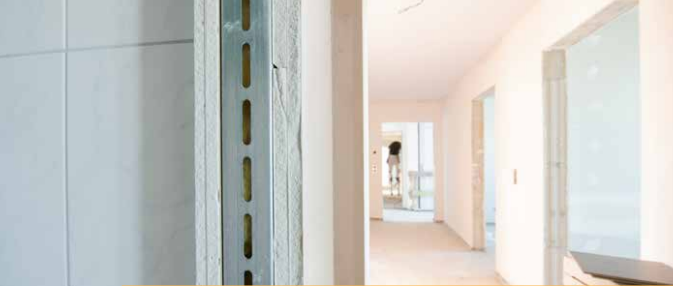
Remscheid, Stuttgarter Straße 1a, Innenausbau
