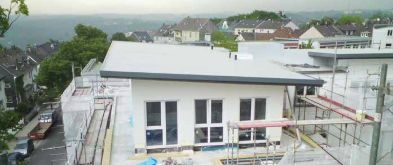
Remscheid, Wilhelmstraße 31 – 33, Dachterrasse mit Aussicht
