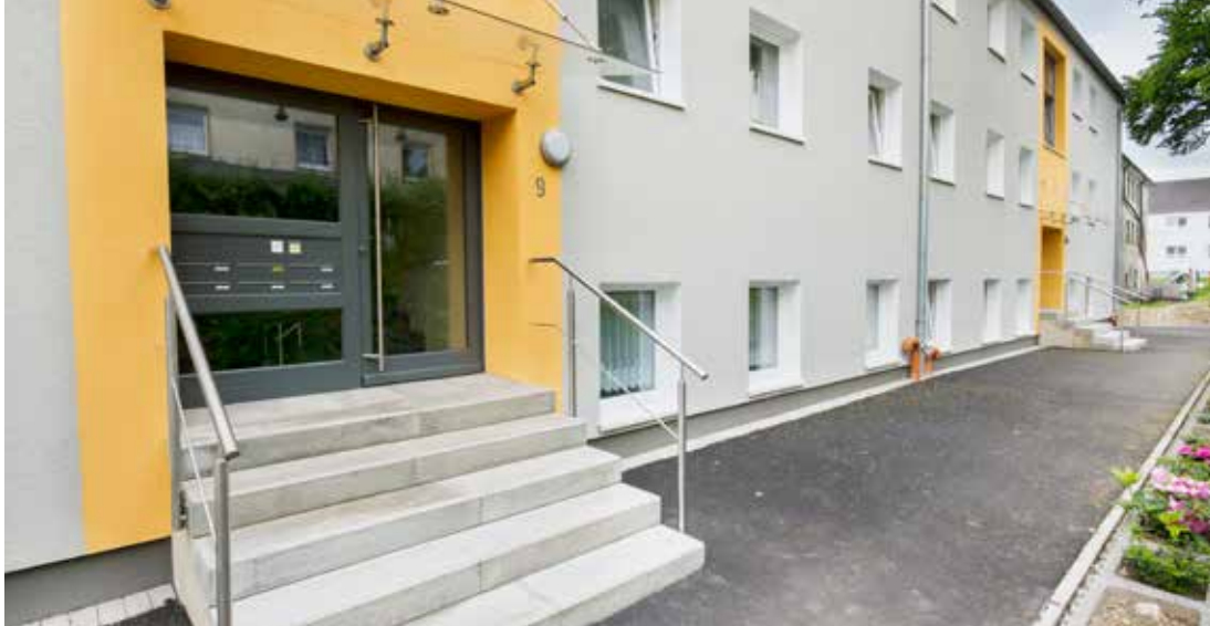
Remscheid, Oststraße 7 – 9, nach energetischer Sanierung
