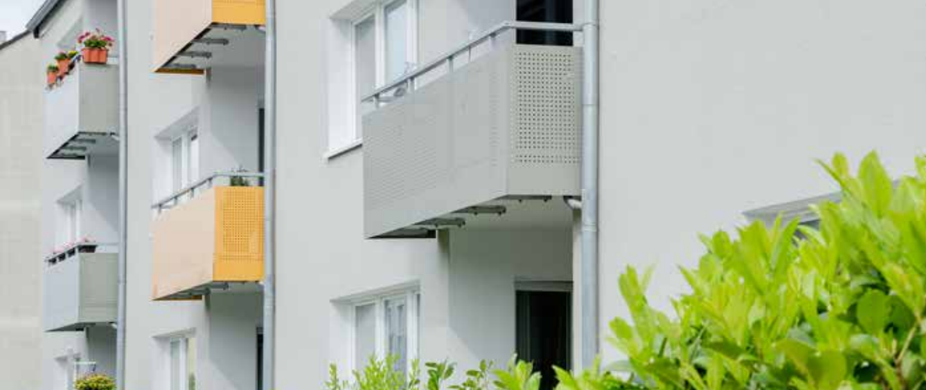
Remscheid, Oststraße 7 – 9, Fassadensanierung mit Balkondetail
