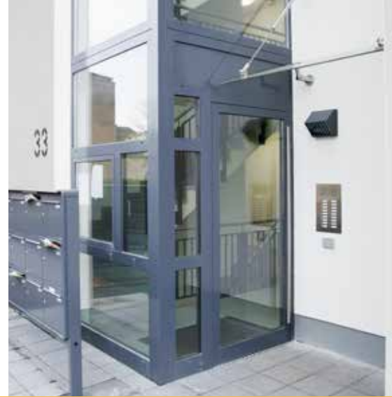
Remscheid, Wilhelmstraße 31 – 33, Glaseingang
